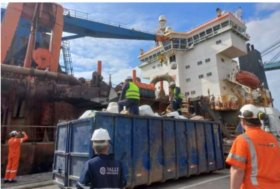
Figura 481: Caminhão Roll-on/Roll-off, utilizado para acondicionamento e transporte dos resíduos retirados da draga.
