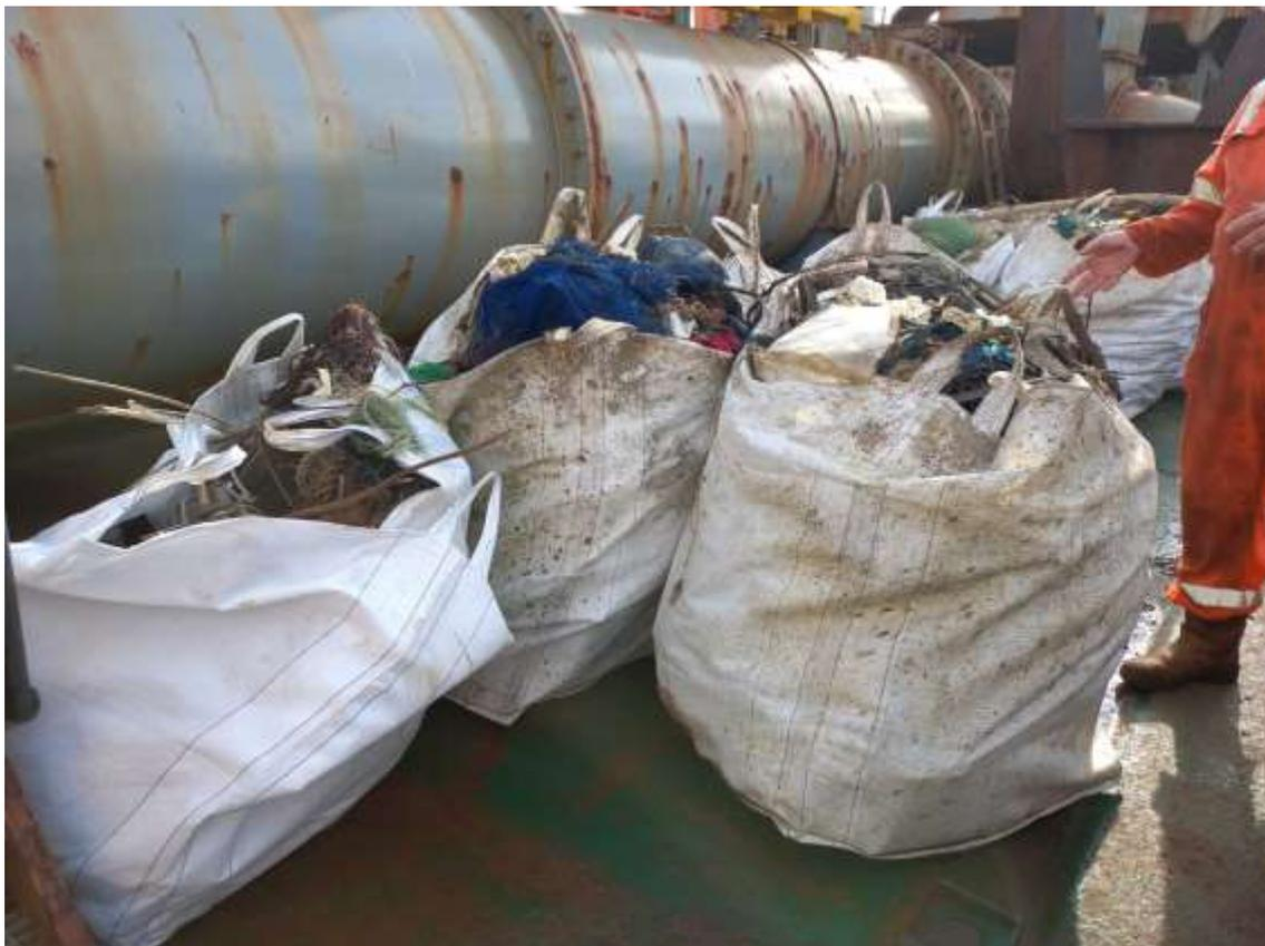
Figura 477: Detalhe da segregação dos resíduos aderidos as cabeças de dragagem direita. Na segunda imagem, percebe-se as caçambas utilizadas para segregação e acondicionamento dos resíduos retirado das cabeças de dragagem após cada ciclo completo.
